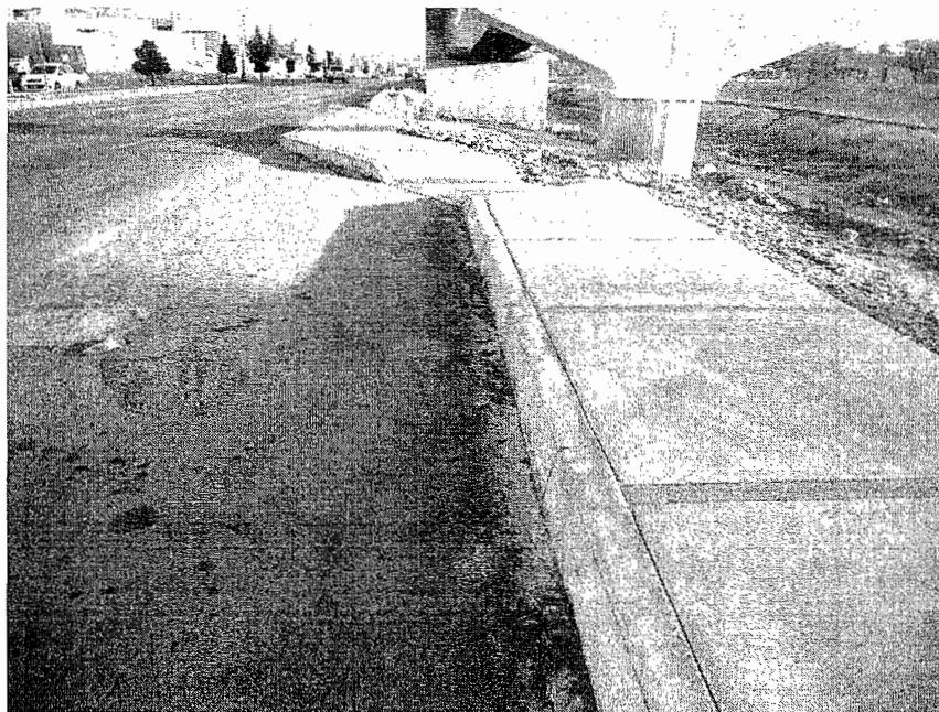
REPOSICION DE MORTERO
