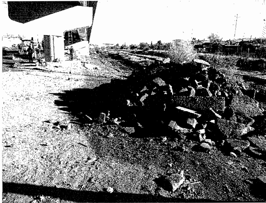
DEMOLICION DE CONCRETO SIMPLE
