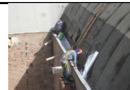
IMPERMEABILIZACIÓN DE CANAL PLUVIAL
