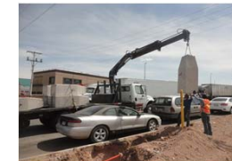
COLOCACIÓN DE BASES DE ARBOTANTES
