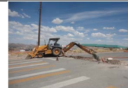
EXCAVACIONES PARA ALOJAR ALIMENTADORES ELECTRICOS
