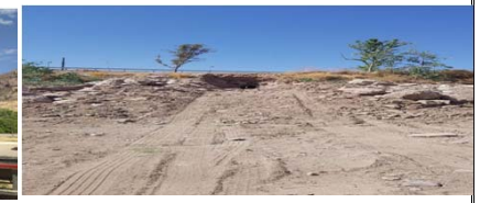
EXCAVACION PARA POZOS DE VISITA Y ZANJA.
