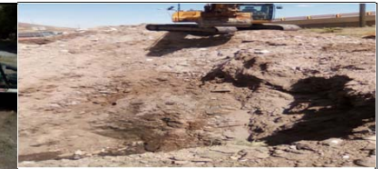
EXCAVACION PARA POZOS DE VISITA Y ZANJA.
