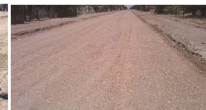
BASE COMPACTADA DEL KM 1+110 AL 1+2500
