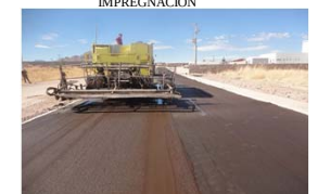
VISTA DE CALLE INDUSTRIAL 1, COLOCACIÓN DE MICROCARPETA
