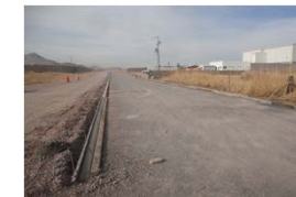
CALLE INDUSTRIAL 1, CONSTRUCCIÓN DE GUARNICIONES Y DENTELLONES
