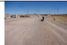
CALLE INDUSTRIAL 1, BASE HIDRÁULICA
