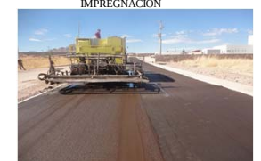
VISTA DE CALLE INDUSTRIAL 1, COLOCACIÓN DE MICROCARPETA
