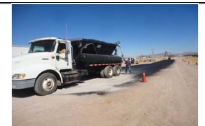
CALLE INDUSTRIAL 1, COLOCACIÓN DE RIEGO DE IMPREGNACIÓN
