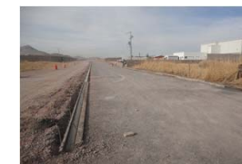
CALLE INDUSTRIAL 1, CONSTRUCCIÓN DE GUARNICIONES Y DENTELLONES
