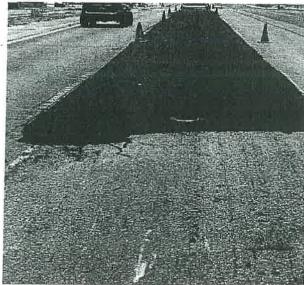
TENDIDO DE LA CAPA DE MICROCARPETA
