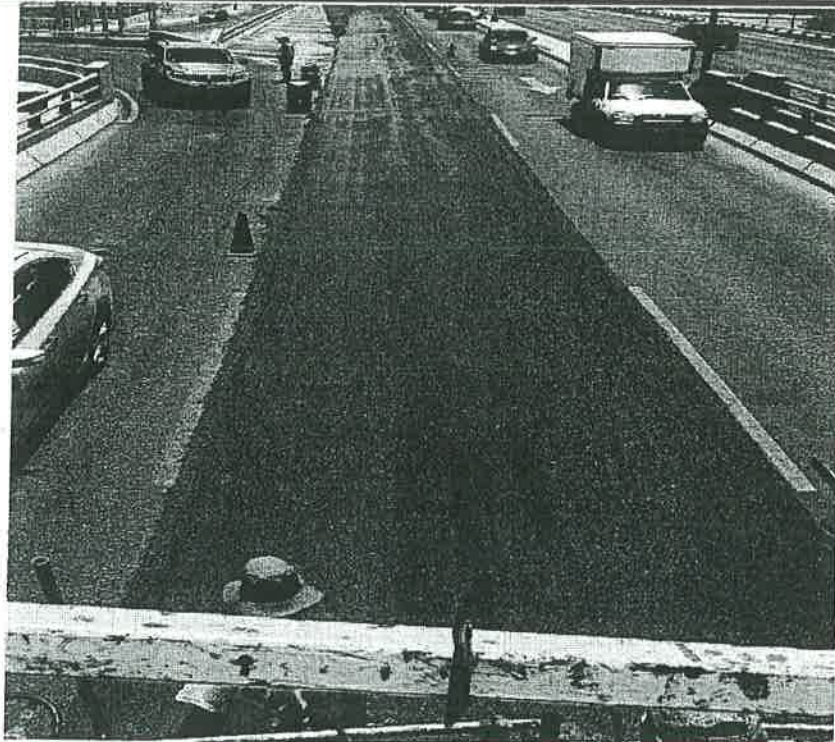
TENDIDO DE LA CAPA DE MICROCARPETA
