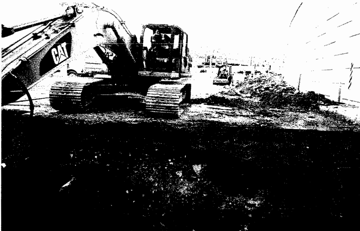
DEMOLICIN DE CARPETA ASFALTICA
