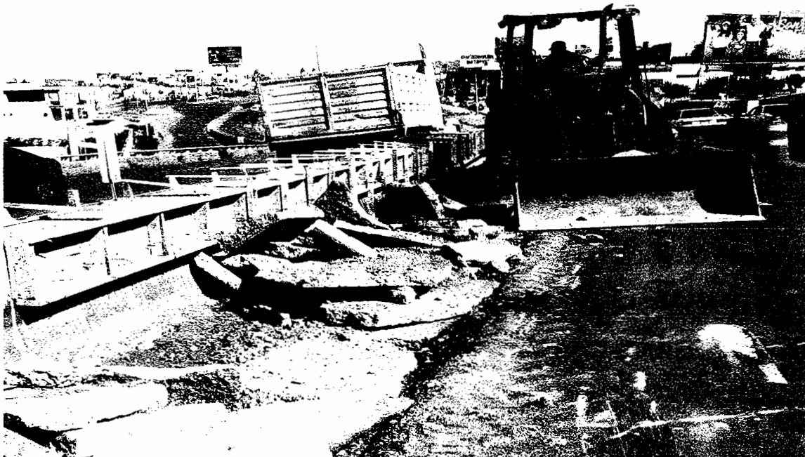
DEMOLICION DE CONCRETO SIMPLE
