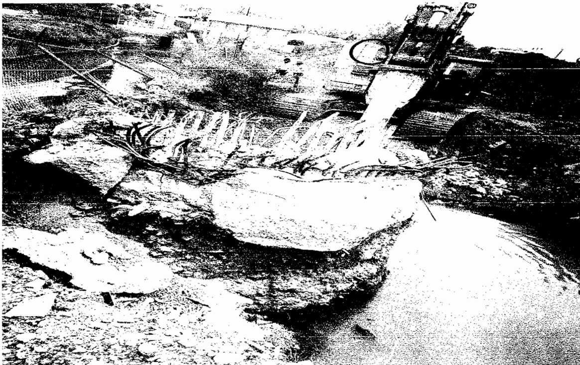
DEMOLICION DE CONCRETO REFORZADO
