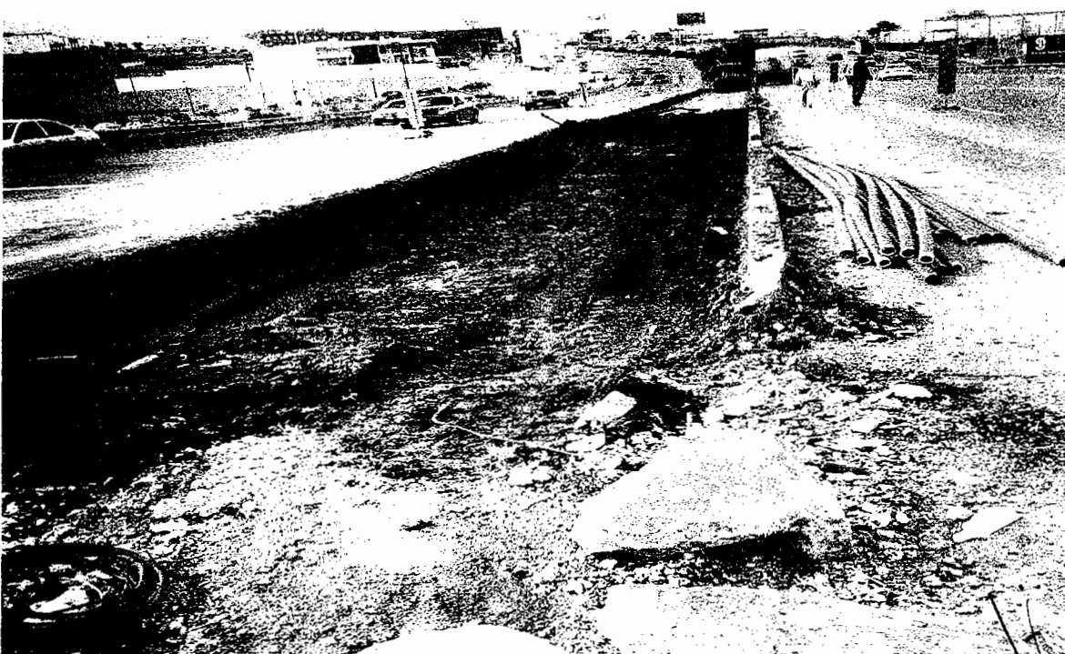
DEMOLICIN DE CARPETA ASFALTICA
