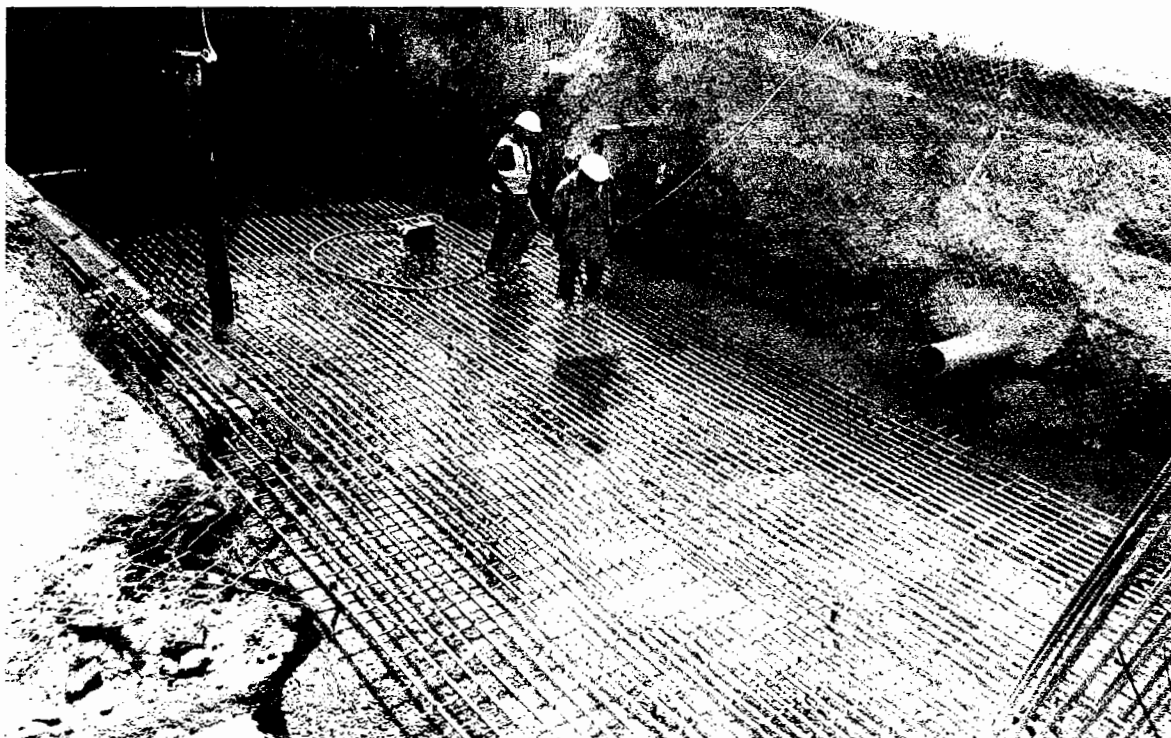
CONCRETO EN ZAPATAS
