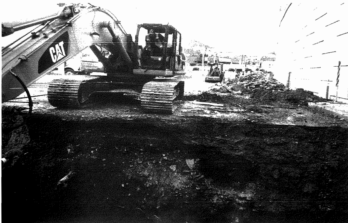
DEMOLICIN DE CARPETA ASFALTICA
