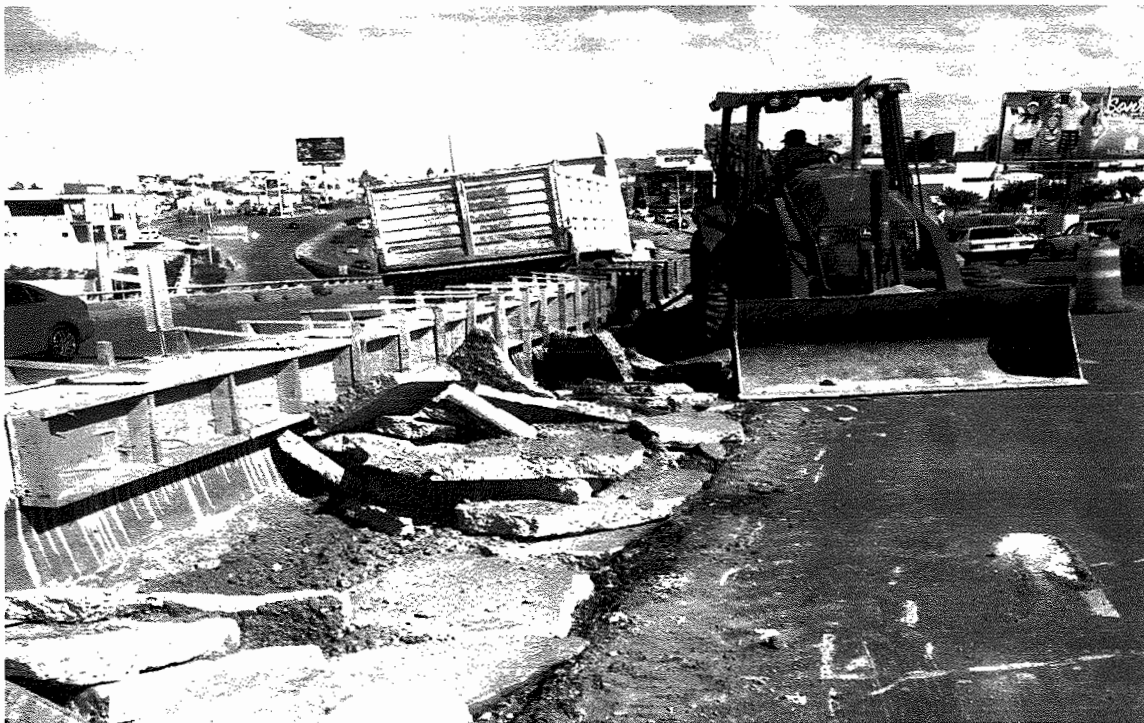
DEMOLICION DE CONCRETO SIMPLE
