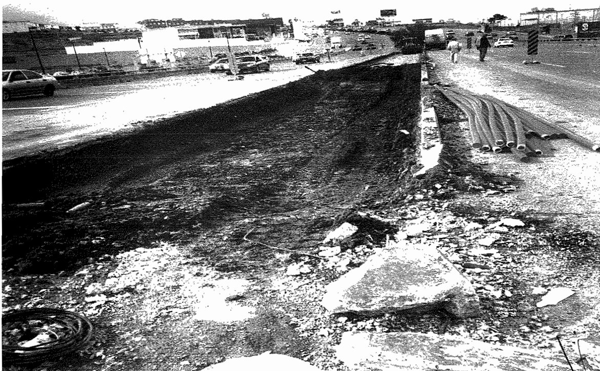
DEMOLICIN DE CARPETA ASFALTICA
