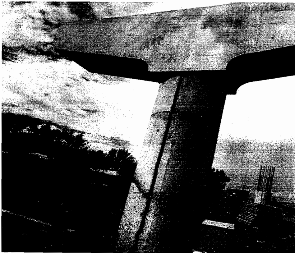
CONCRETO EN COLUMNAS
