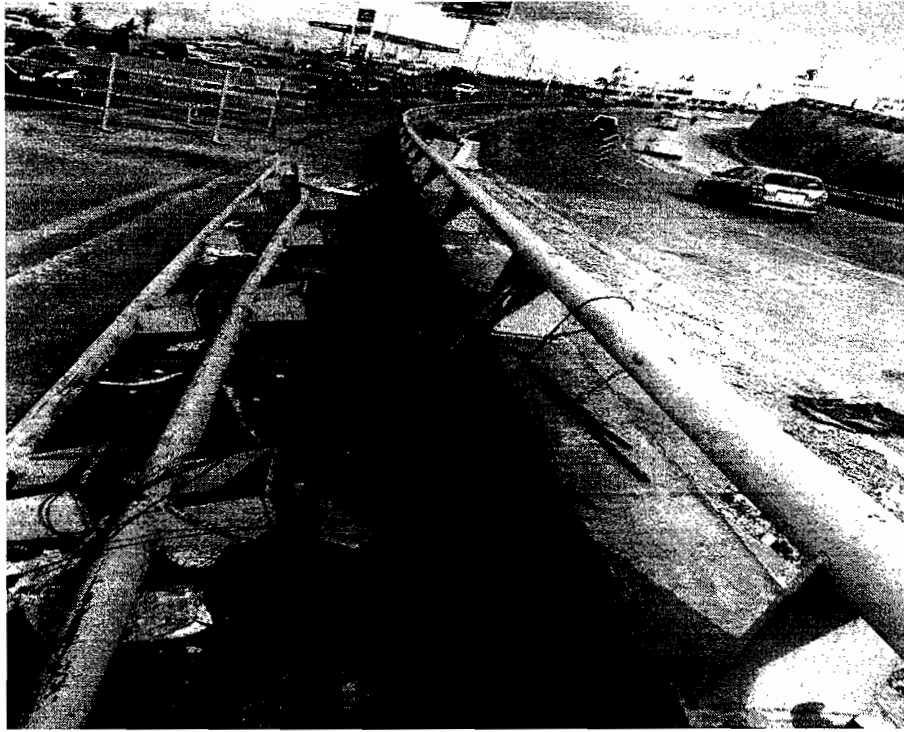
DESMANTELAMIENTO DE PARAPETO
