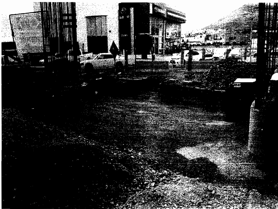
RELLENO DE EXCAVACIÓN PARA ESTRUCTURAS
