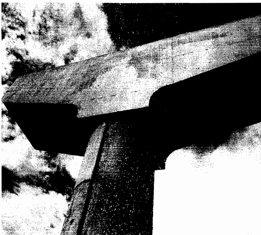
CONCRETO EN CABEZAL
