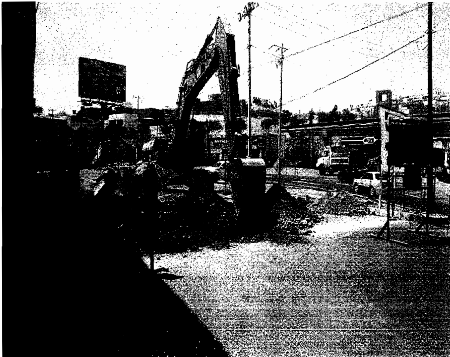
DEMOLICION DE CARPETA ASFALTICA
