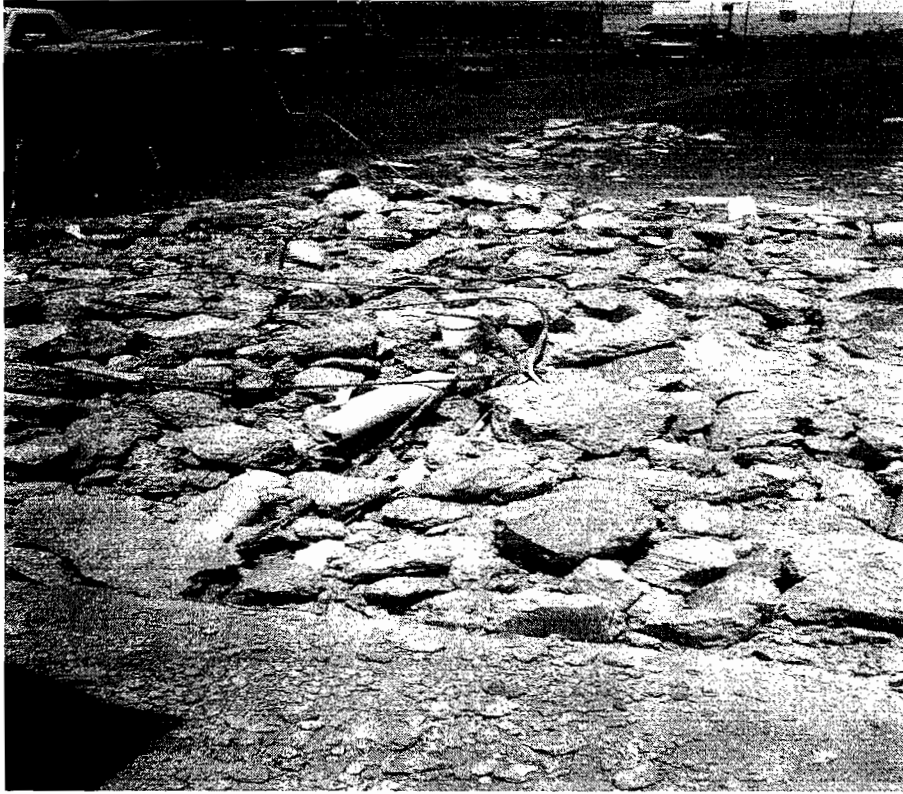
DEMOLICION DE CONCRETO REFORZADO
