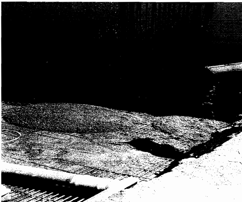
CONCRETO HIDRAULICO EN ZAPATAS
