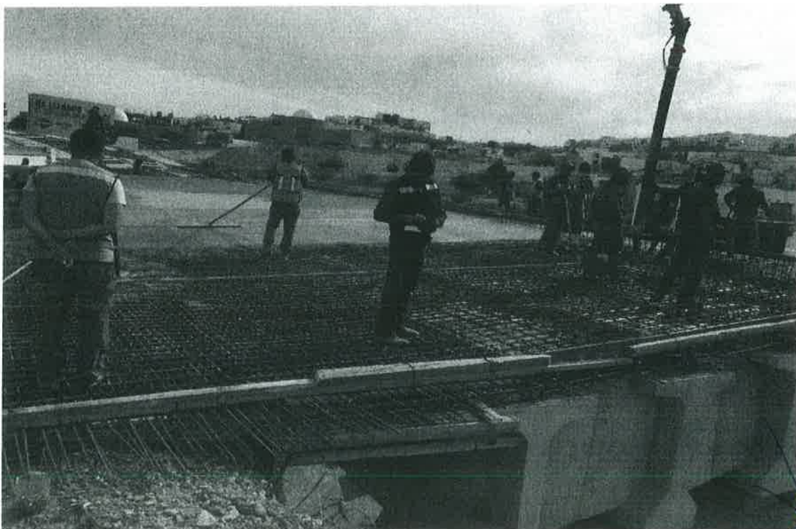
CONCRETO EN LOSAS
