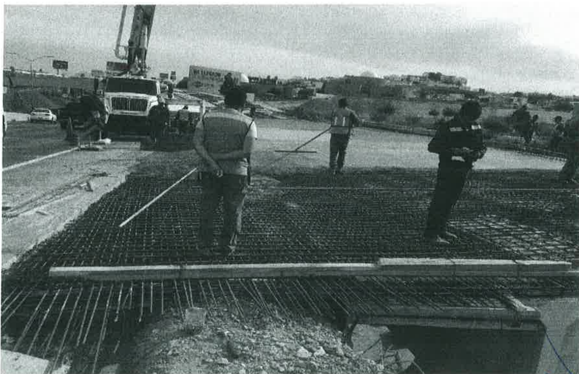
ACERO DE REFUERZO
