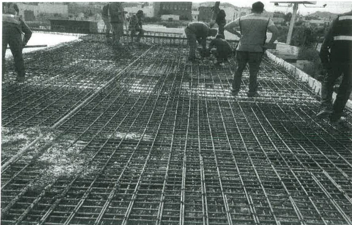
ACERO DE REFUERZO
