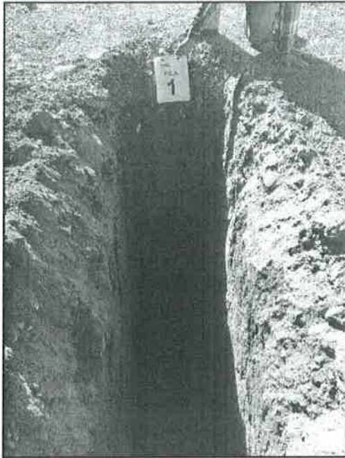
EXCAVACION DEL PRIMER SONDEO (PCA-1)
