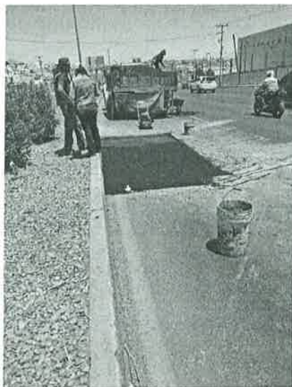
REPARACIÓN DE FALLA
