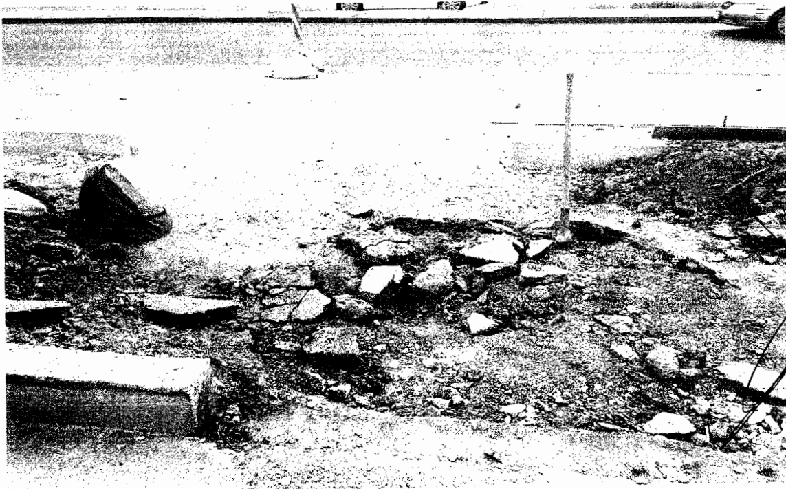
DEMOLICION DE CARPETA ASFALTICA
