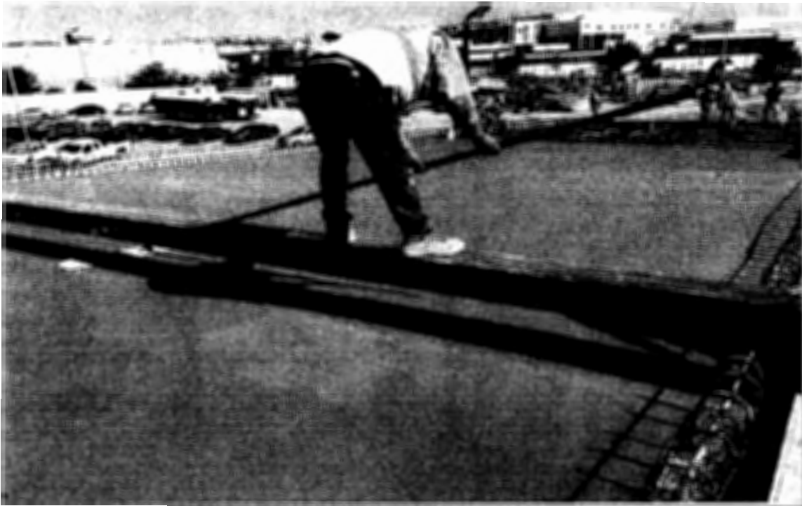
CONCRETO EN LOSA
