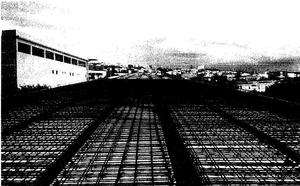
HABILITADO DE ACERO
