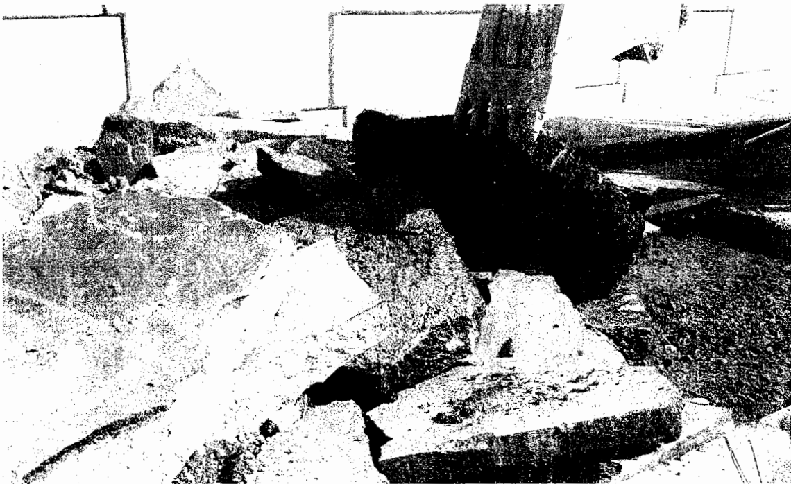
DEMOLICION DE CONCRETO ASFALTICO
