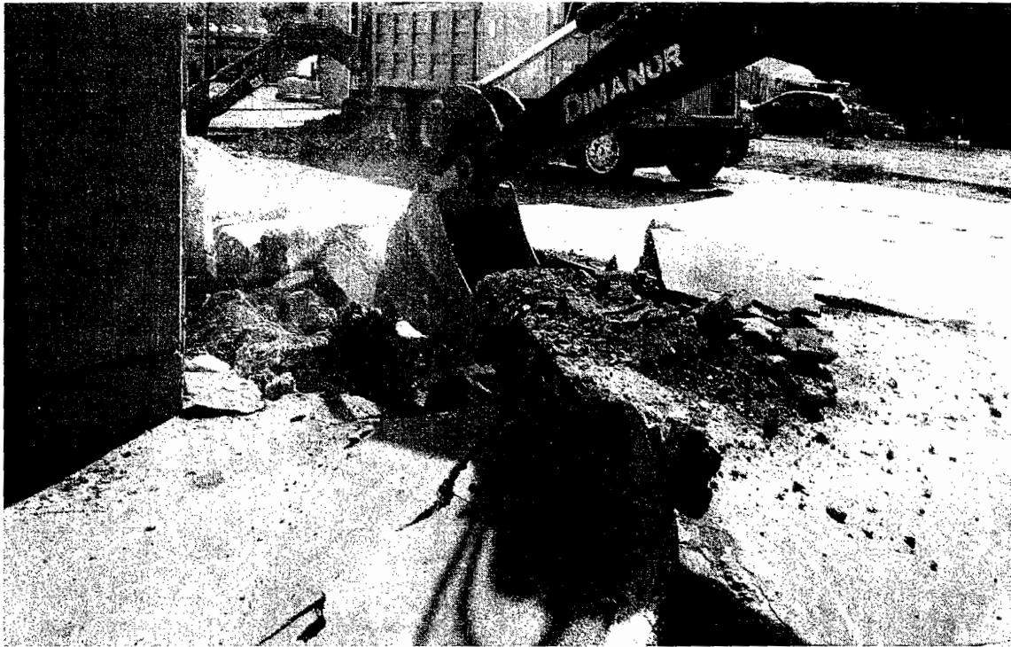
DEMOLICION DE CONCRETO SIMPLE
