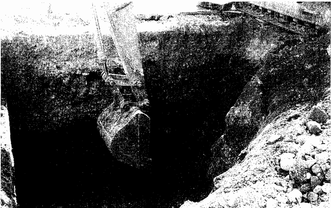
EXCAVACION PARA ESTRUCTURAS
