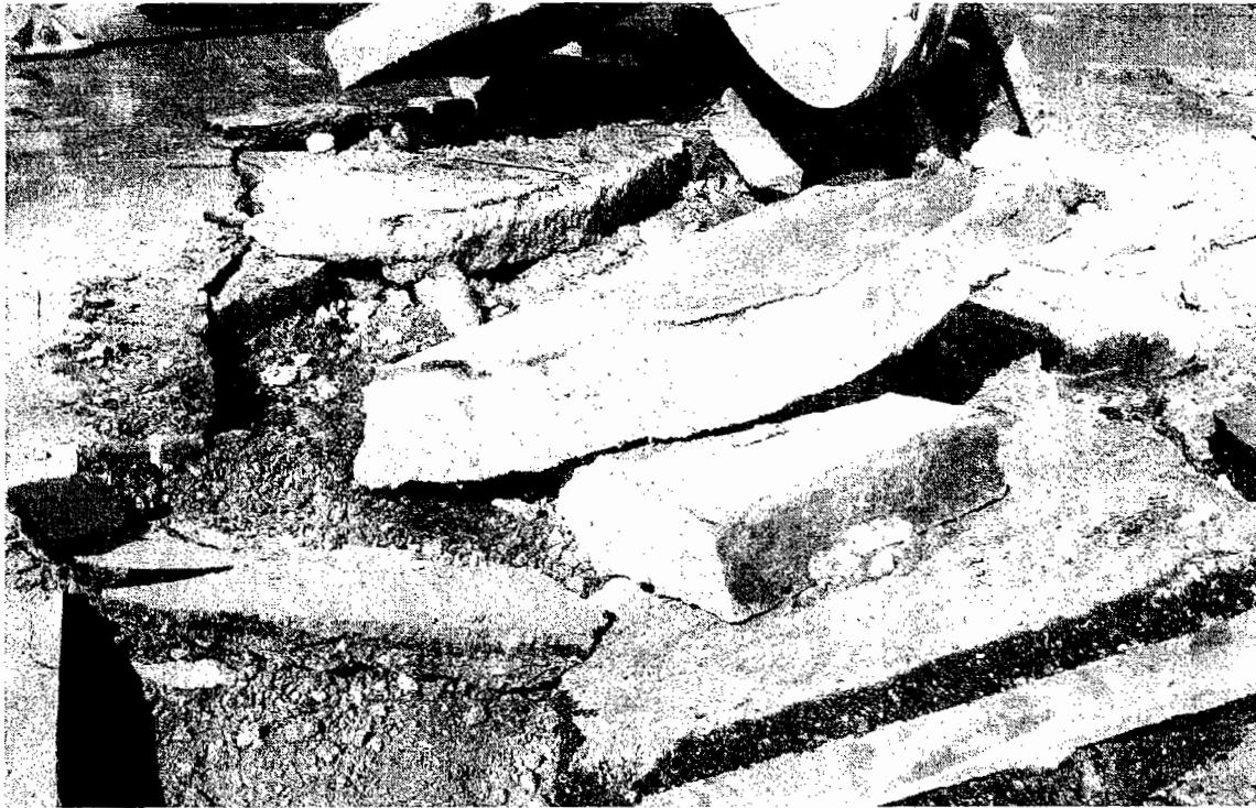
DEMOLICION DE CONCRETO ASFALTICO
