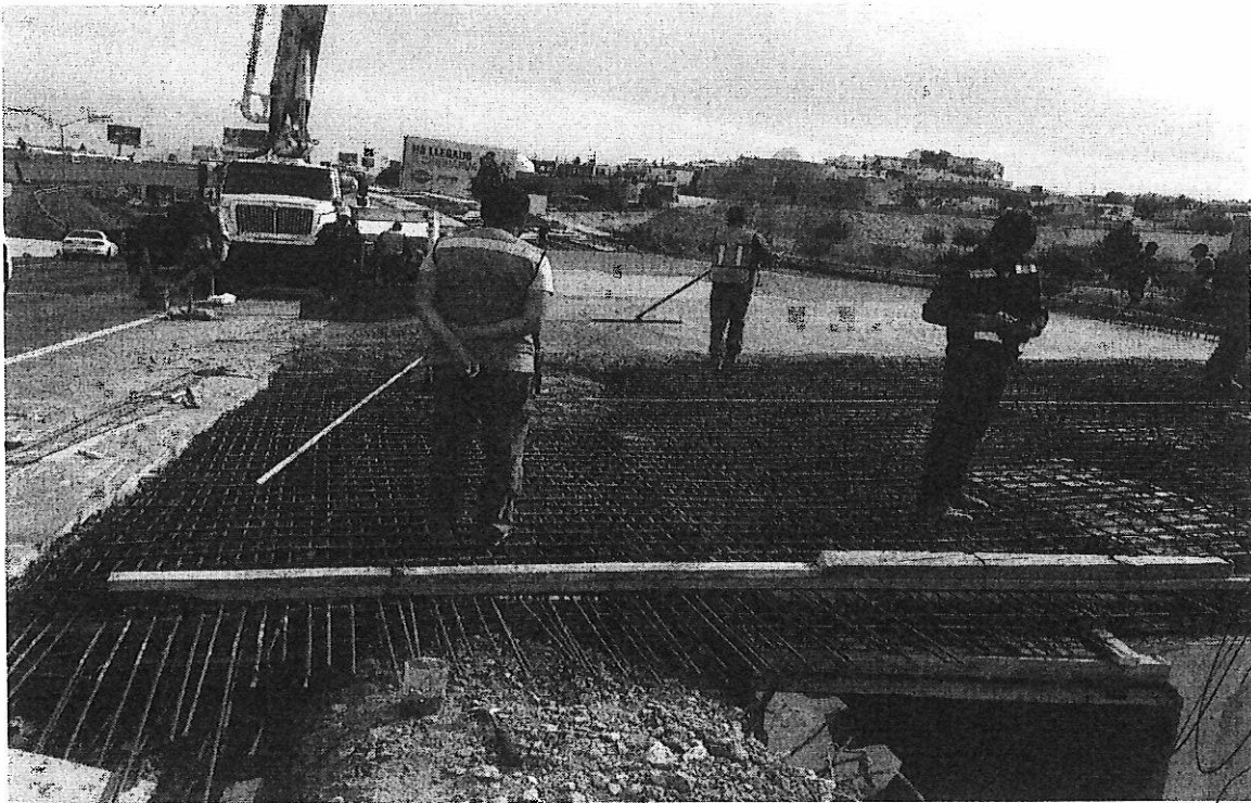
ACERO DE REFUERZO
