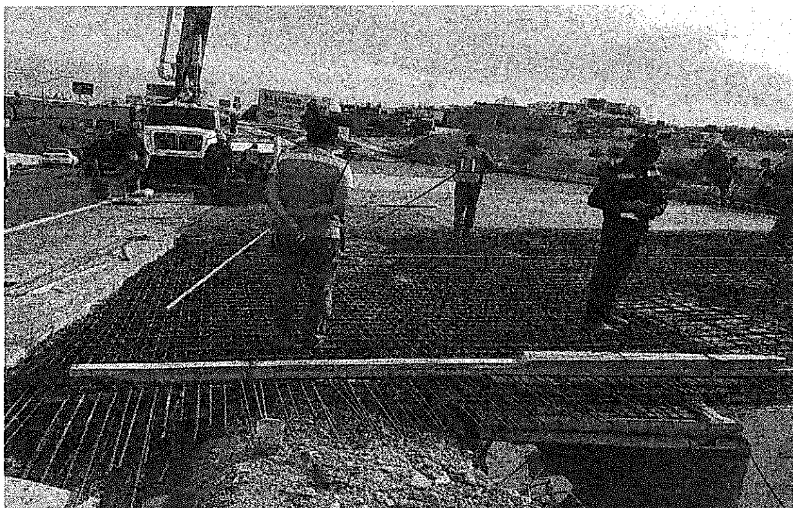
ACERO DE REFUERZO
