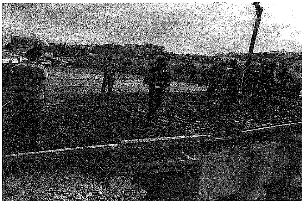
CONCRETO EN LOSAS
