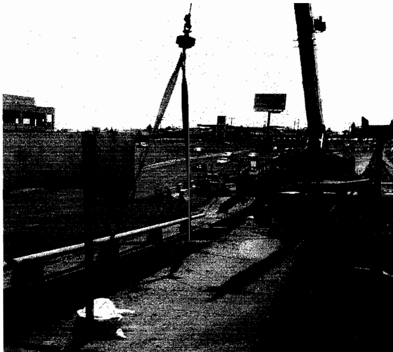
DESMANTELAMIENTO DE PARAPETO METALICO
