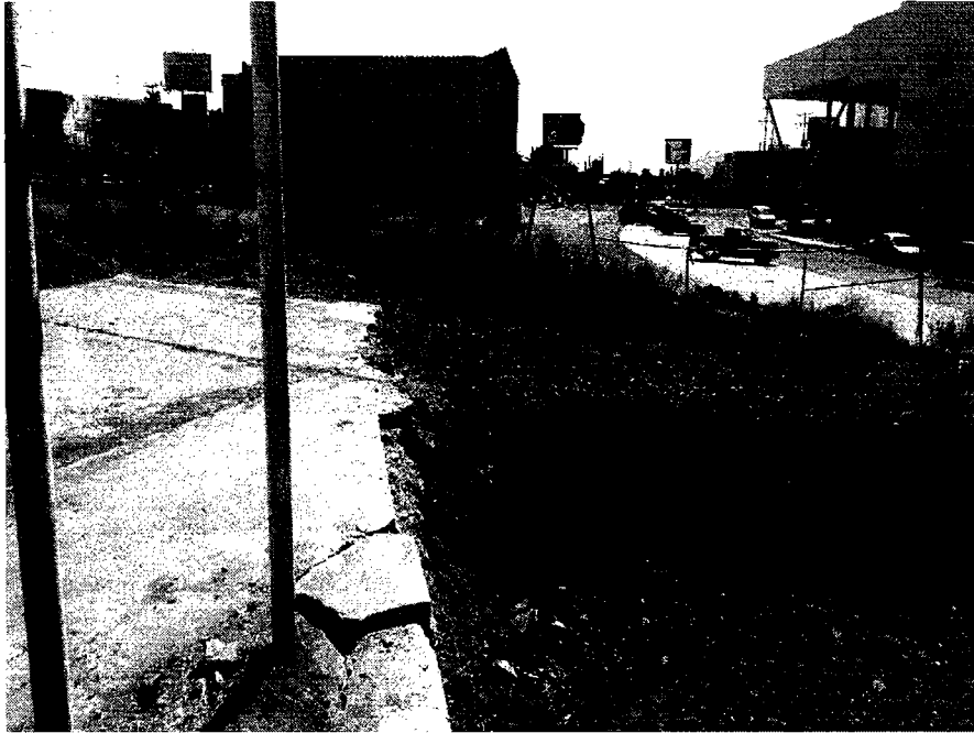
DEMOLICION DE CONCRETO SIMPLE
