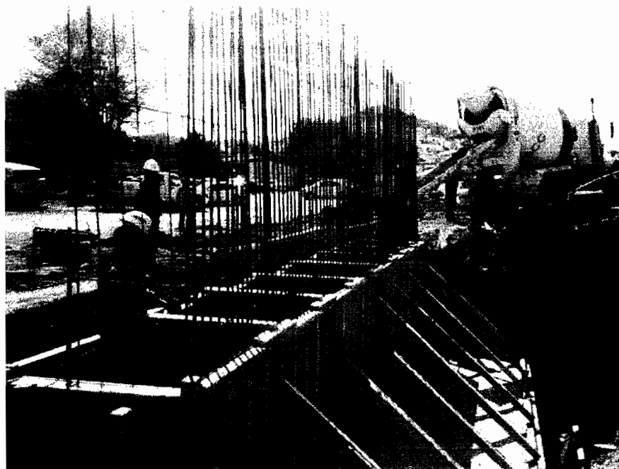
COLOCACION DE ACERO EN MURO DE ESTRIBO
