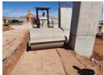
RELLENO Y COMPACTACION EN PILA 2
