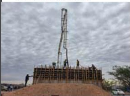
COLADO DE ESTRIBO 1 TERCERA SECCION
