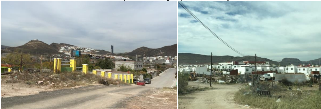
Imagen 33. Falta de pavimentos y vialidades estrechas. Fuente: Obtención propia en campo.
