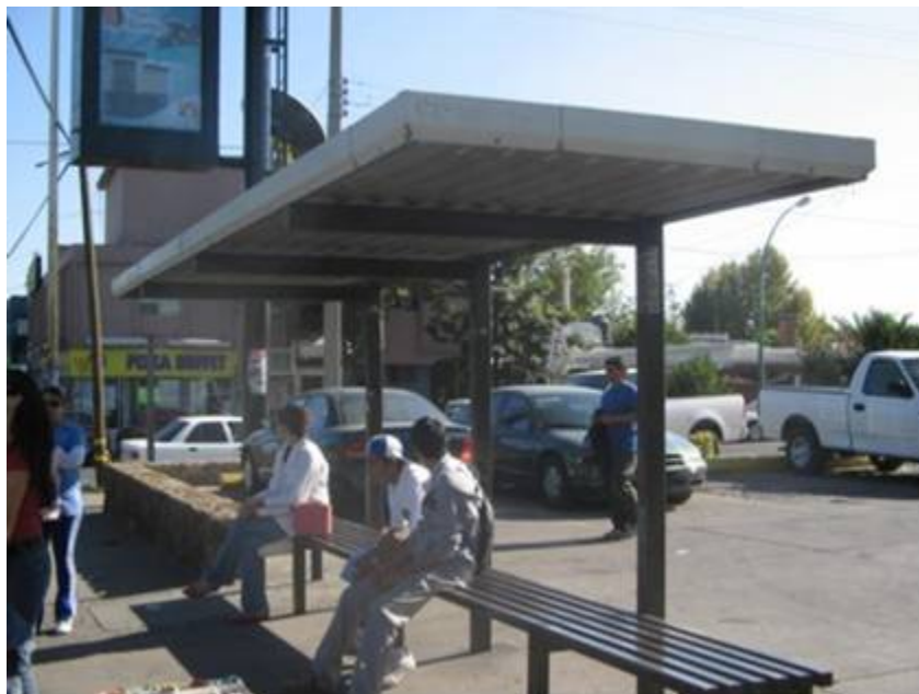
Imagen 5.5 Paradero de cobertura sencilla
