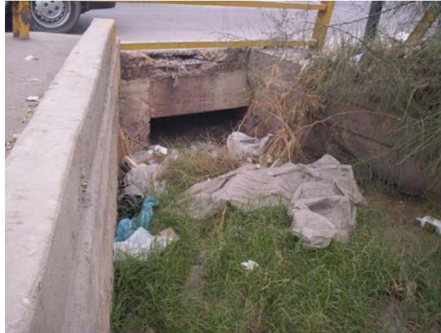
Figura 3.12 Obras de Drenaje
