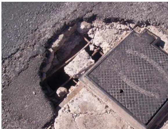
Figura 3.15 Caja de Válvulas
