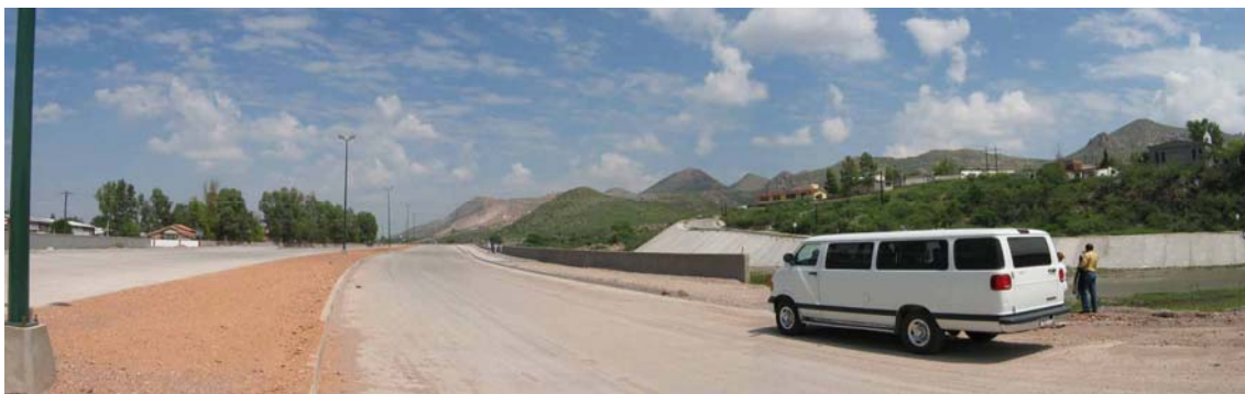
Imagen 2.10 Vialidad Sacramento en Construcción
