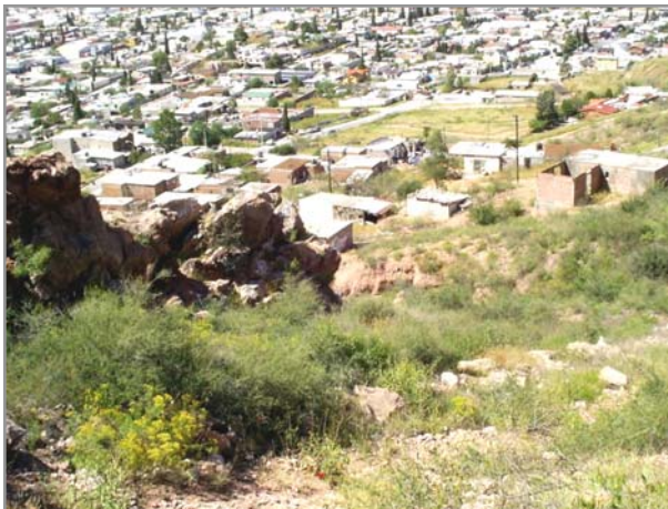
Figura V.1.1.16. Cerro Coronel y derrumbes.
