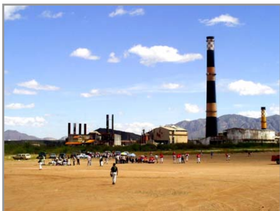
Figura V.1.3.10. Industrial Minera México. Lugar: Industrial Minera México (Fundición Ávalos).
