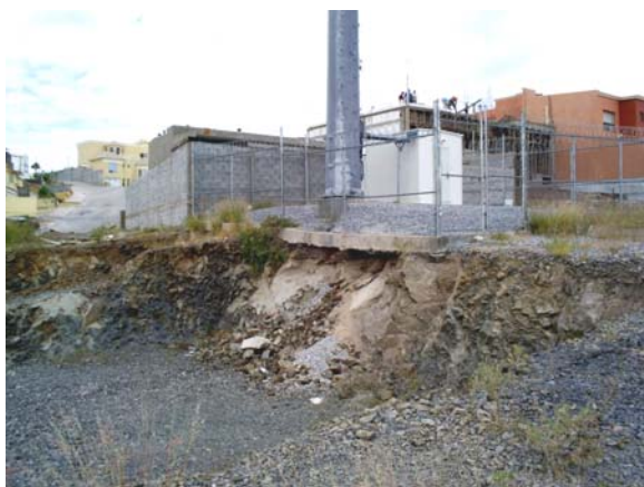
Figura V.1.1.5. Fracc. Vista Real. Lugar: Fraccionamiento Vista Real. Pegada a la agencia Dodge Periférico de la Juventud. Coordenadas: 0390084 3168601
