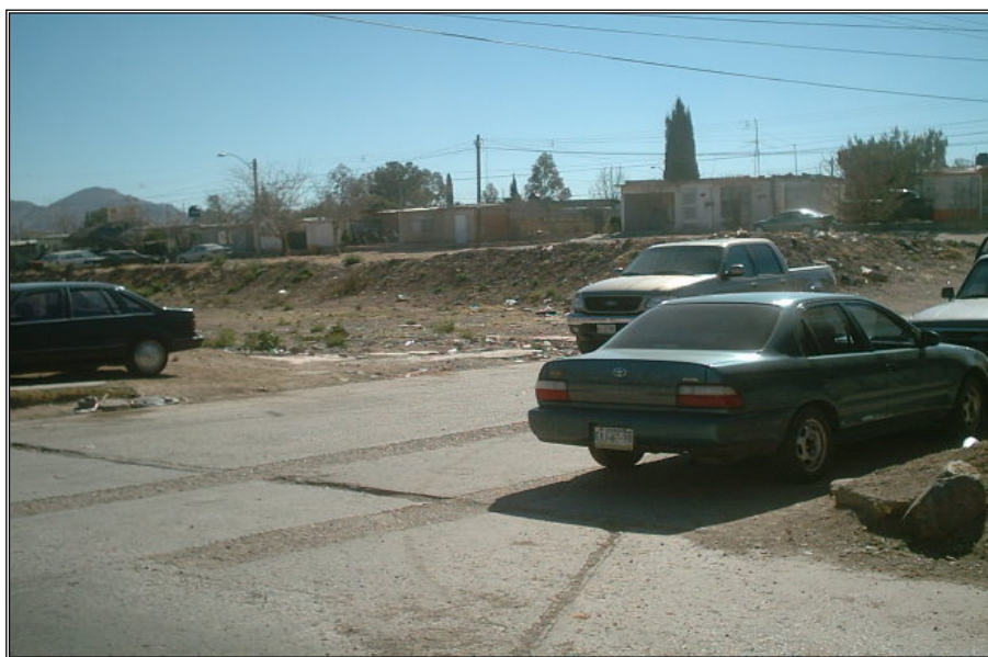
Foto V.2.3.2. (MA 0+965) Coordenadas: 392007E, 3174413N y elevación de 1456 msnm. Vista aguas abajo del cauce natural del arroyo a la altura de la calle Columbus.
