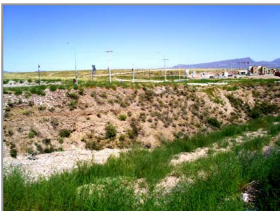
Figura V.1.3.12. Arroyo Fracc. Colinas del León. Lugar: Fraccionamiento Colinas del León. Coordenadas: 0399169 3172458
