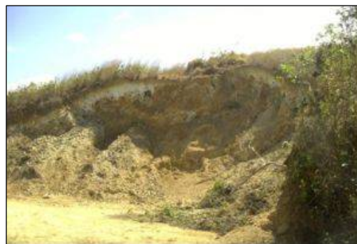
Figura IV.1.6.1. Erosión por deslizamiento en material saturado.
